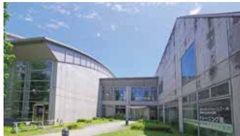
横山公園／さがみはらグリーンプール
